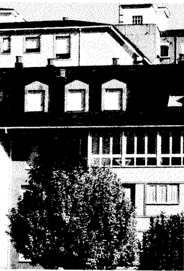
la demolición parcial. PEPA LOSADA
