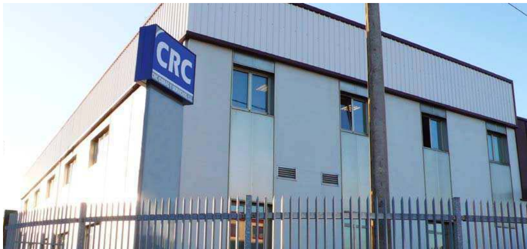
Sede de CRC Obras y Servicios en la localidad coruñesa de Órdes
