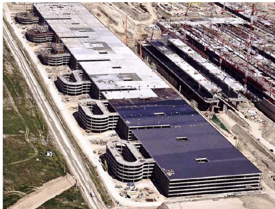
Hierros Santa Cruz participó en la construcción de la T4 del aeropuerto de Barajas
