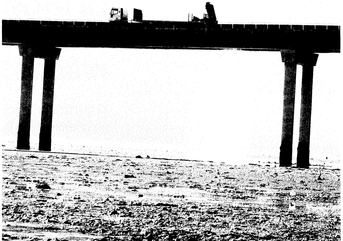
Las fugas en las redes de distribución, sean por deterioro o por accidente, constituyen uno de los problemas más graves. La foto fue tomada con motivo de la rotura de la tubería que circula por el puente de Cespon, sobre la ría de Arousa | ALBERTO HEVIA
